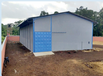
Magasin de Stockage CNCC de Kribi Région du Sud
