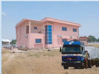
Centre de vie CNCC de Kousséri Région de l'Extrême-Nord
