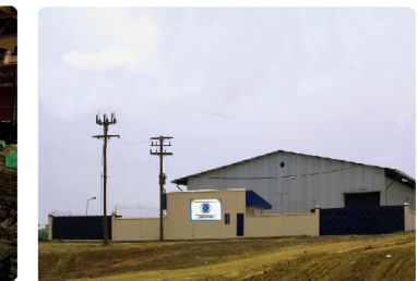
Magasin de Stockage CNCC de Douala | Bassa - Région du Littoral CNCC Douala | Bassa Cargo Warehouse - Littoral Region
