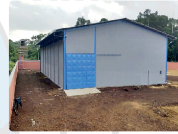
Magasin de Stockage du Centre de vie CNCC de Kribi - Région du Sud CNCC Kribi Trucker Accommodation Centre Cargo Warehouse - South Region
