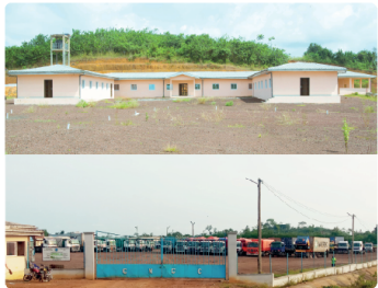
Centre de vie CNCC de la Dohanda - Région du Littoral Dohanda CNCC Trucker Accommodation Centre - Littoral Region
